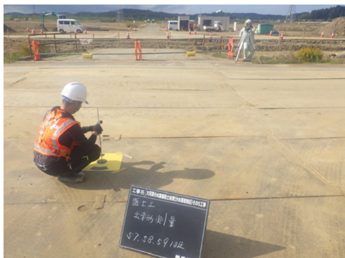
対空標識設置 / 計測
