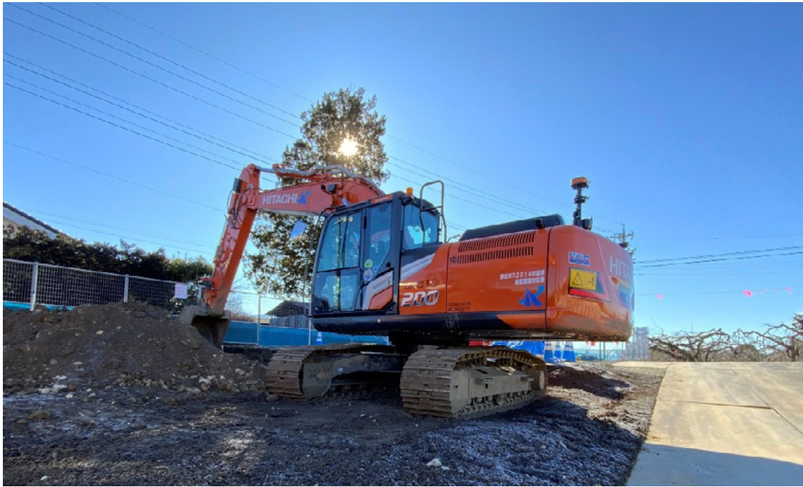
SL-MG による施工
