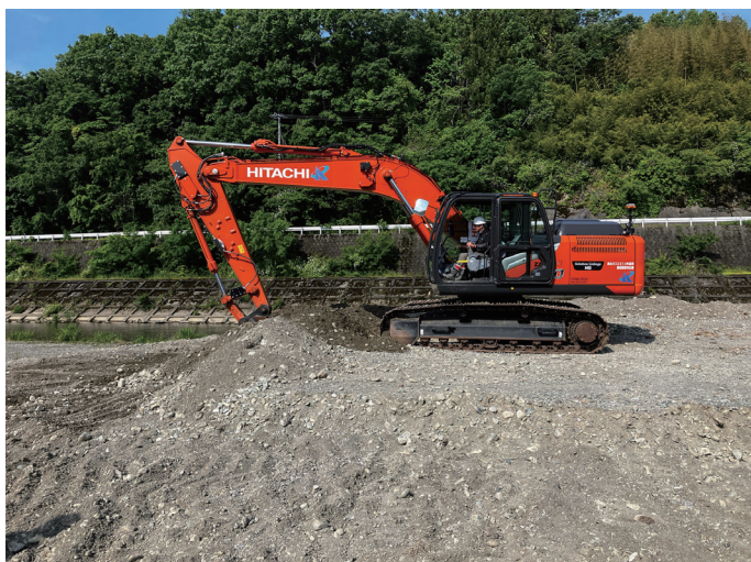
ZX200-7(SL-MG 仕様) による粗掘削作業
