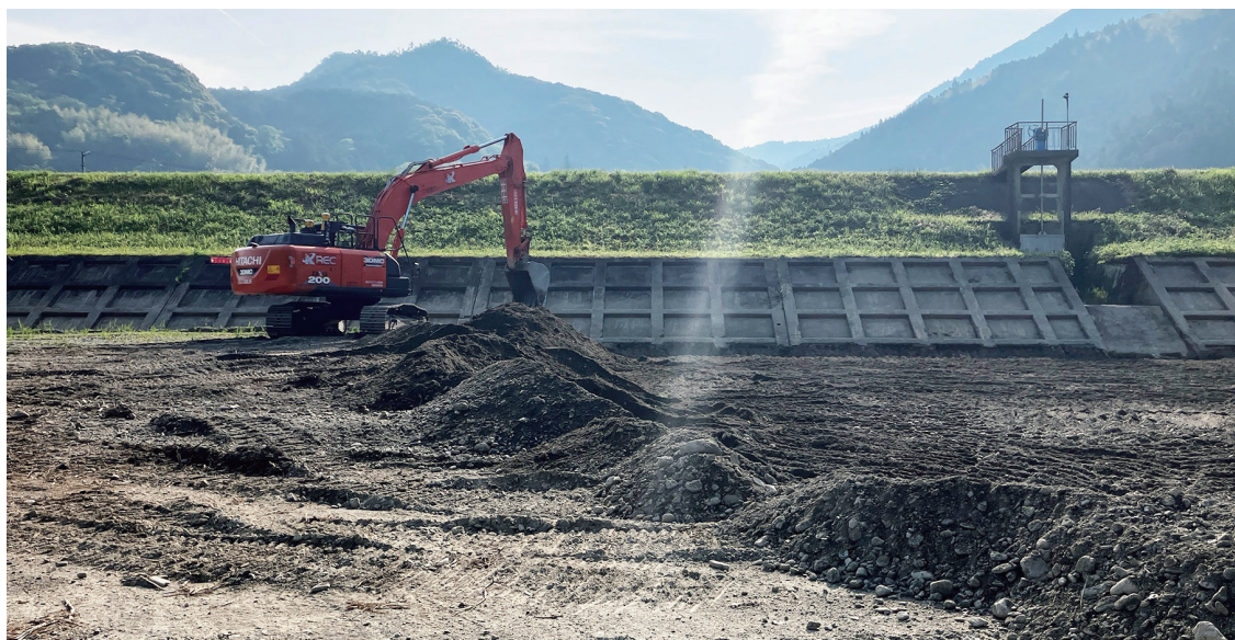
ZX200X-6(SL-Assist 仕様) を使用した掘削作業
