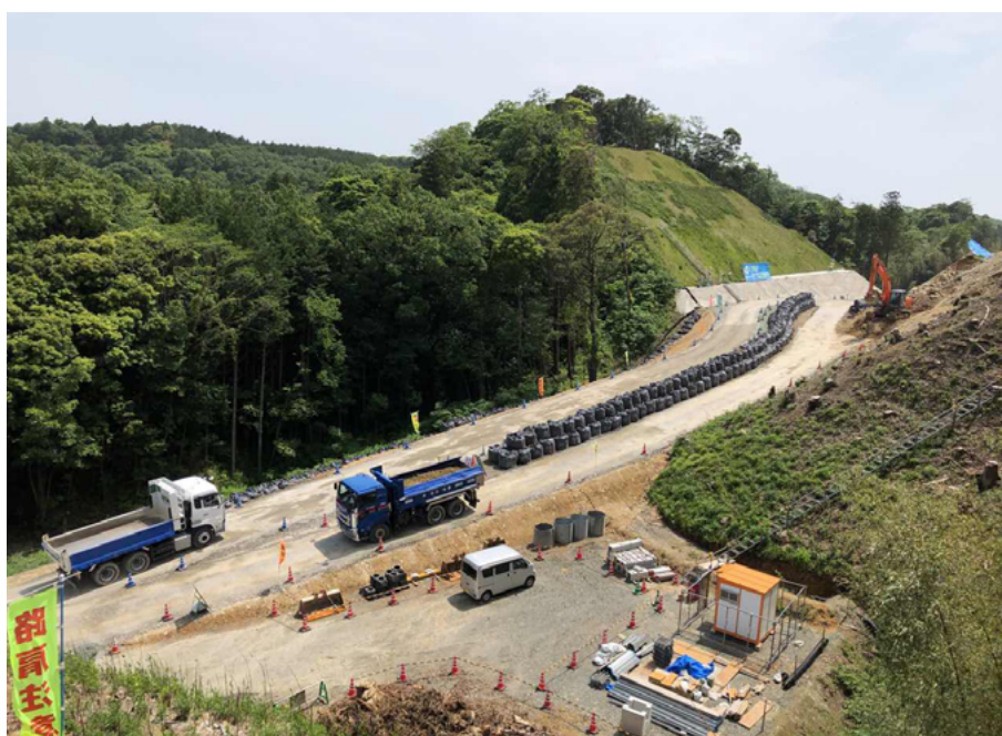
落石防止用の大型土のうを設置して車両通行帯をつくり工程への影響を抑える
