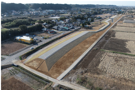
「完成した現場」
