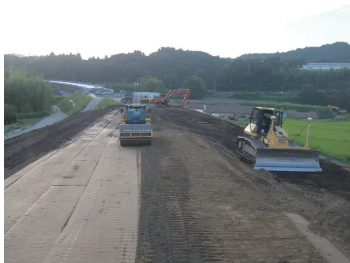
盛土を施工する ICT ブルドーザー
