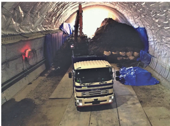
位置情報によってダンプトラックが指定エリアに入ったことをスマートフォンに通知
