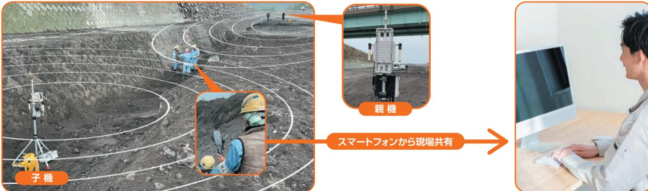
Solution Linkage Wi-Fi の親機(右上)と子機(左下)を設置し、施工現場に通信環境を提供します。
