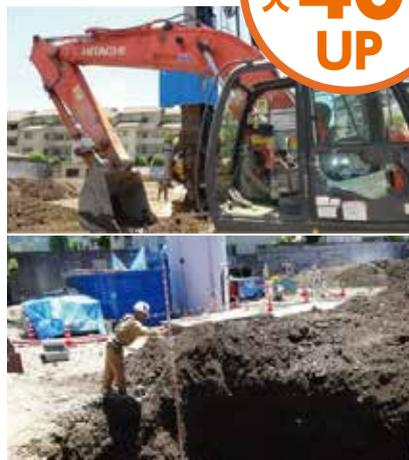
3m前後の深さで精度3cmを求められ、測量に費やす時間が甚大でした。導入後は最小限に抑えられました。車両が傾いても、チルトセンサーで傾きの補正が出来、安定した精度を得る事ができました。
